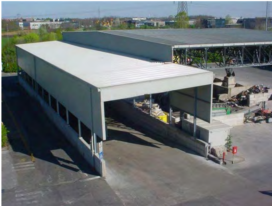
Fig. 8 : Stazione di trasferimento di Bellusco-Mezzago
